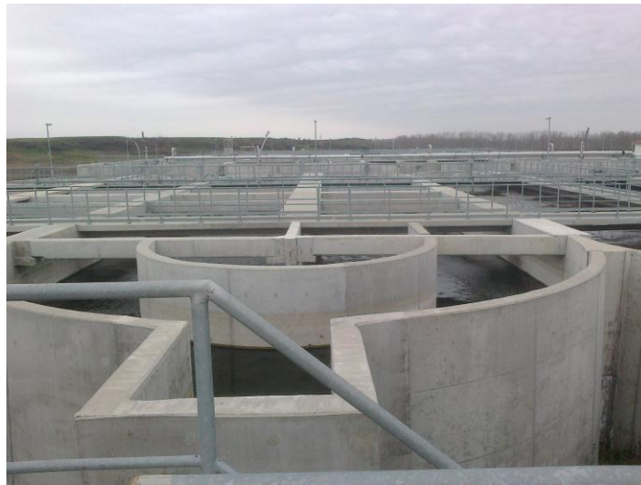
Fig. 2-Camera de distributie secțiunea bio-fosfor
