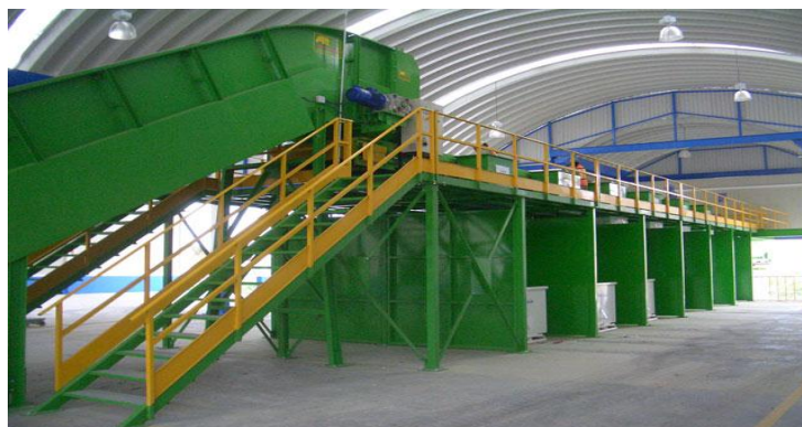
Instalație de sortare în conformitate cu normele europene
