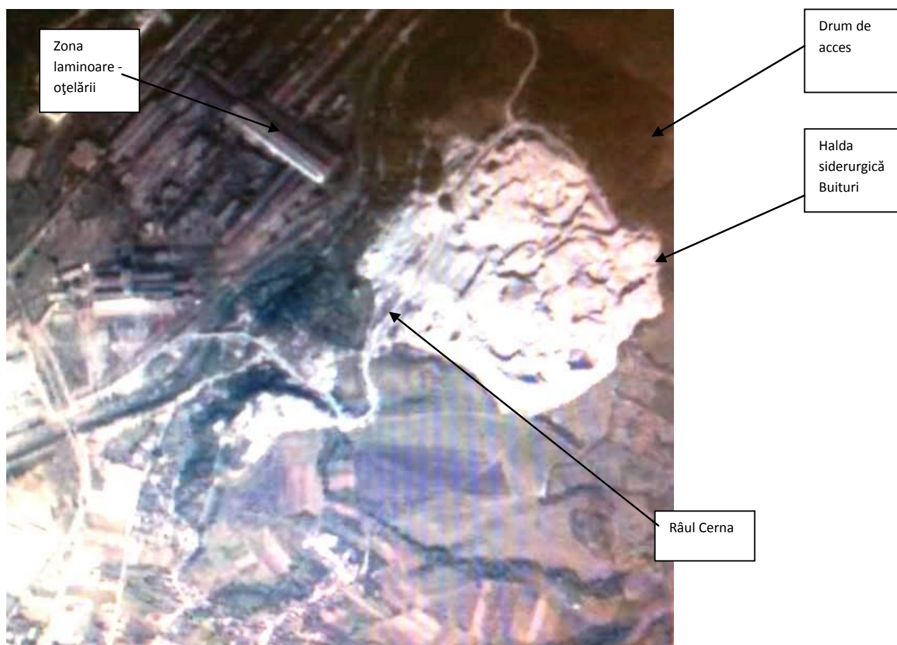
Vedere de ansamblu al amplasamentului haldei
