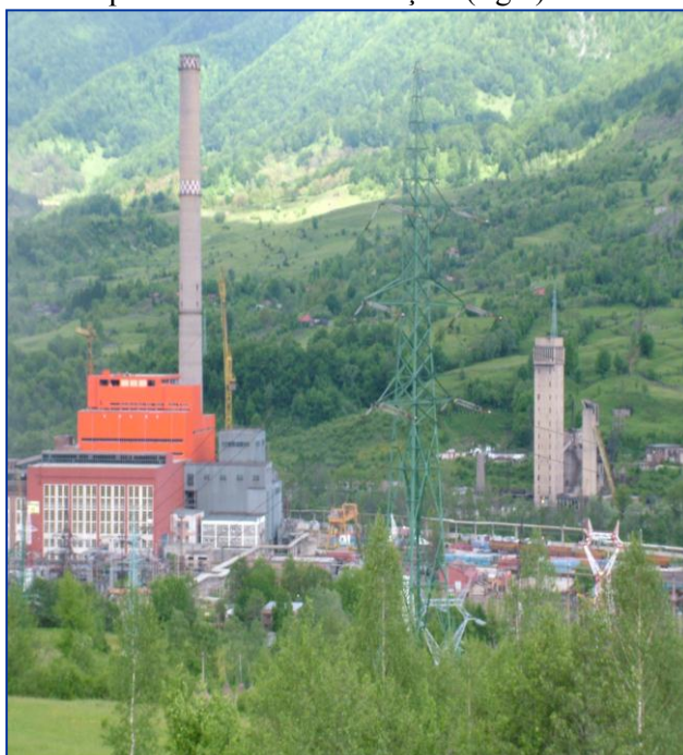
Fig.2. Vedere generală C.E.T. Paroșeni
